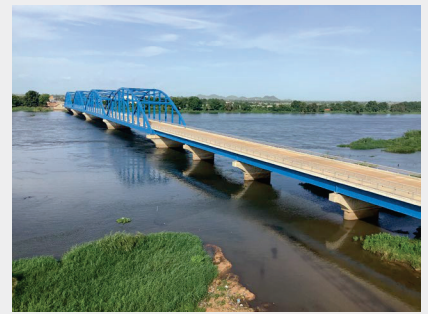
南スーダンに自由への架け橋を！フリーダムブリッジの設計と施工
