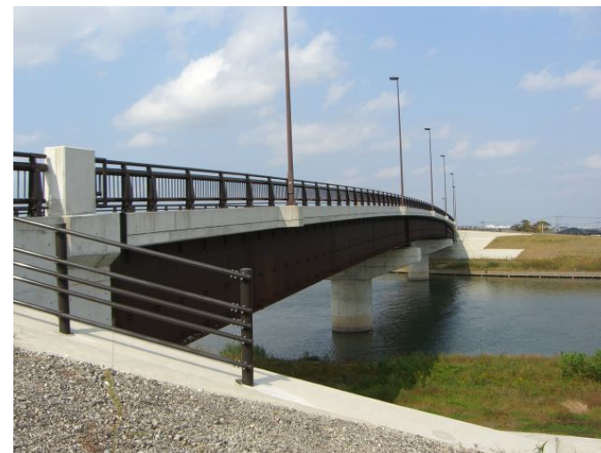
図-10 建設1年6カ月後の周辺状況
