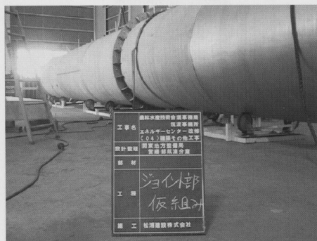
写真4. 工場での仮組作業
